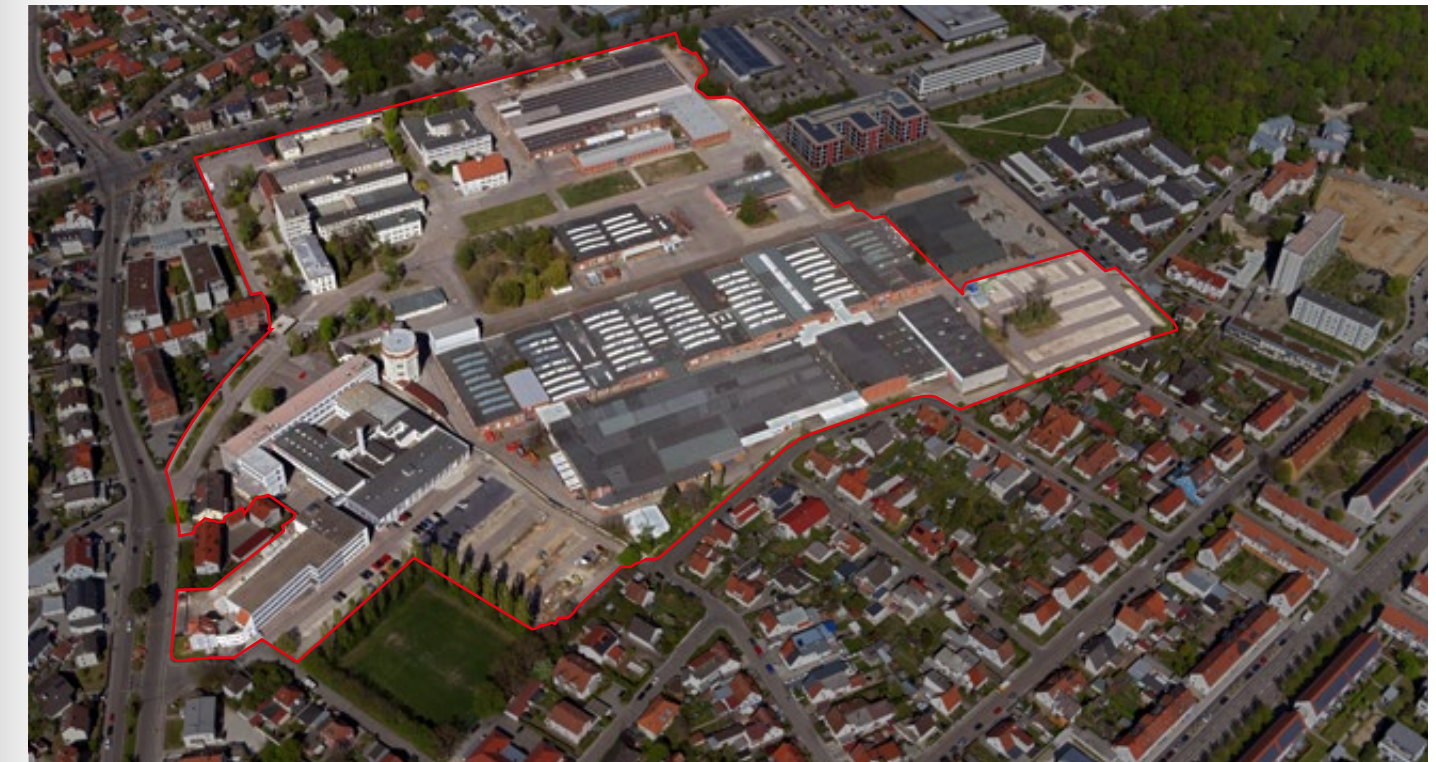
Abgrenzung INquartier vor den Rückbaumaßnahmen
